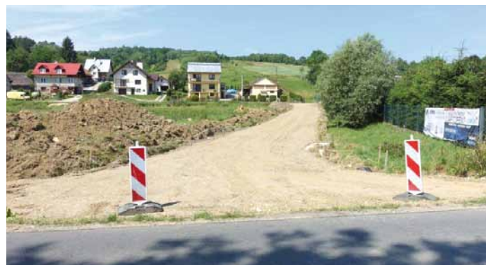
Remont ulicy Karolówka
