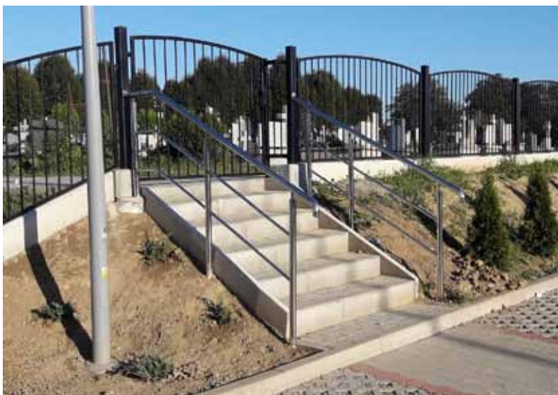
Fot. A. Owsiny Fragment ogrodzenia parkingu od strony cmentarza
